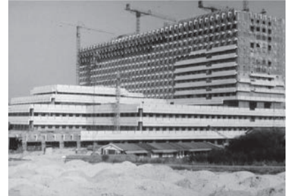
Saint-Luc en construction.
